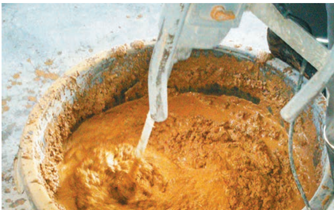
Rozmiešanie omietky nízkootáčkovým miešadlom
